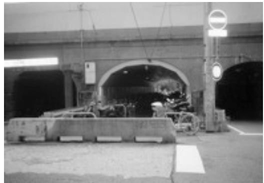
写真11 甲子園口北町4-28東側の橋 (JR神戸線南側)
