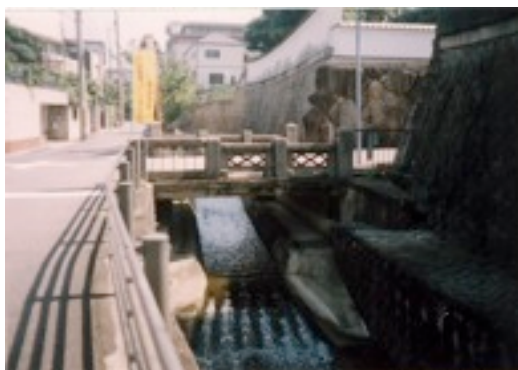
写真13 甲子園口2丁目19-17の橋
