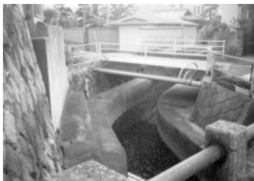
写真12 上甲子園3丁目10-10南東側の橋
