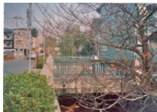
写真9 円満橋 [甲子園口2丁目3-19]
