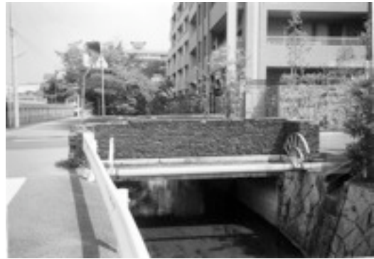
写真4 松並町5-40東側の橋
