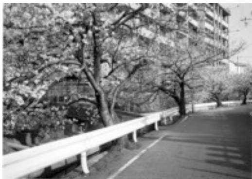
写真6 松並町7-1個人宅への橋
