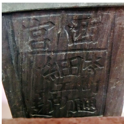
写真7 水管の「西宮本町通」銘 (岡本家1)
