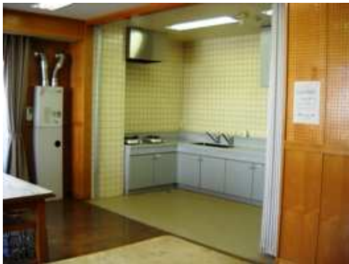
▲シンク、ガスコンロ、湯沸し器があります。
