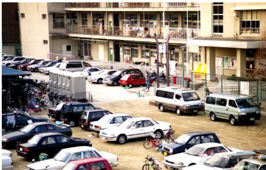
避難所となった西宮市立総合教育センター（平成7年）
