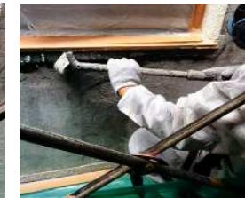
大気中のアスベスト 粉塵濃度測定（作業中）
