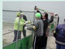
立入制限フェンスの設置
