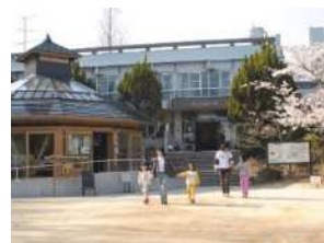
図 5-6 甲山自然環境センター
