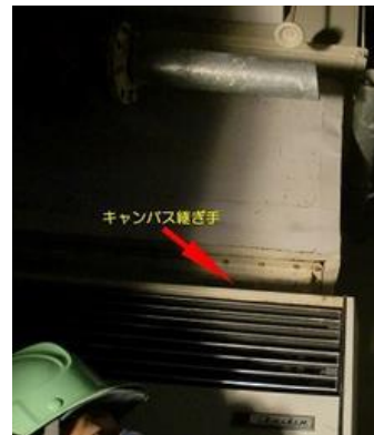
（参考資料）写真 6－11 キャンバス継ぎ手
