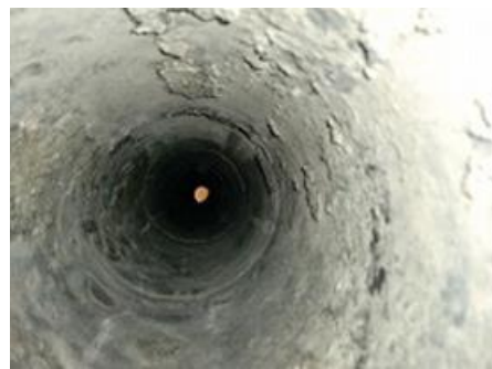
(参考資料) 写真6-5 ライナー付き カポスタック煙突断熱材
