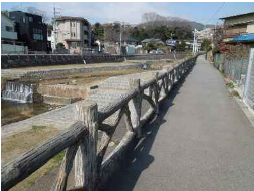
河川の転落防護柵を擬木にして周辺の景観に馴染ませています。
