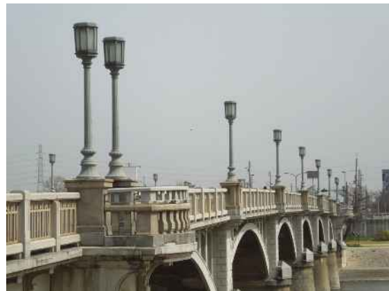
近景では高欄部と橋中央部のバルコニーが特徴的です。
