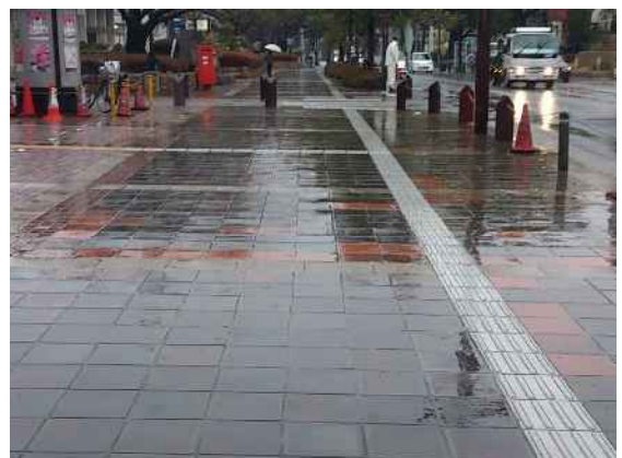
雨天時には舗装材の色彩が濃くなり、表面が反射することで印象が変わります。
