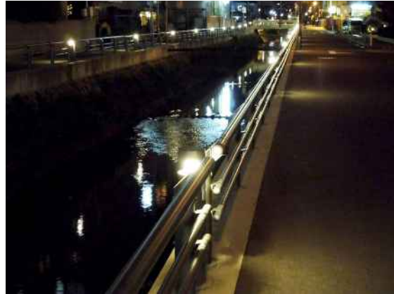
高欄に組み込んだ照明が夜間景観を演出しています。
