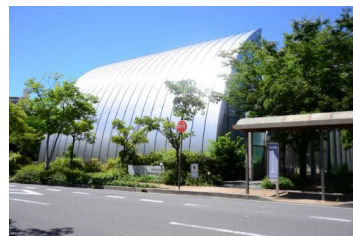
壁面との区別がつかない屋根の例
