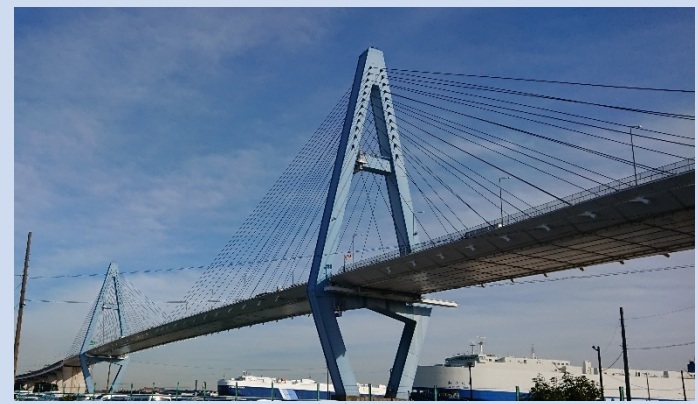
斜張橋デザインのイメージ (斜張橋_名港東大橋_愛知県名古屋市)
