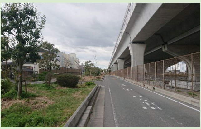
沿道緑化(郊外部)のイメージ (第二京阪交野北IC(南側)_大阪府交野市)
