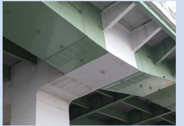
上部工と下部工の一体的デザインのイメージ (阪神高速道路-海老江JCT付近_大阪府大阪市)
