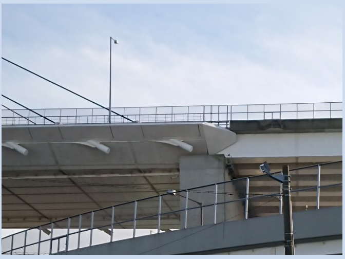
橋種変化点でのデザイン処理のイメージ (伊勢湾岸自動車道-名港トリトン_愛知県名古屋市)
