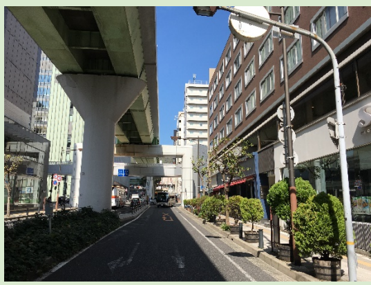
沿道緑化(市街地部)のイメージ (国道2号(ポータルライナー高架下)_兵庫県三宮市)
