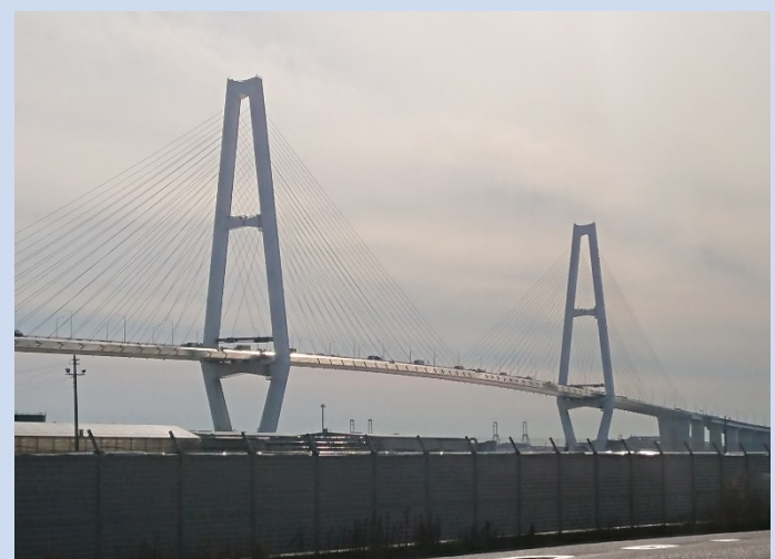
斜張橋デザインのイメージ (斜張橋_名港中央大橋_愛知県名古屋市)
