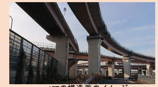
JCTの構造美のイメージ (名古屋南JCT_愛知県名古屋市)
