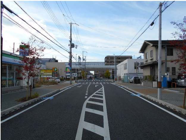
都市計画道路の整備・連続立体交差事業（競馬場線）
