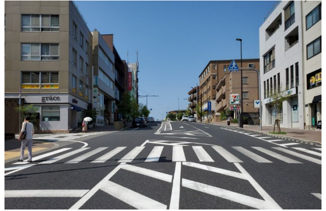
電線共同溝による無電柱化（山手幹線）
