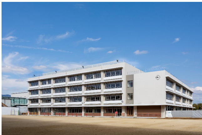
校舎の建替え（春風小学校）
