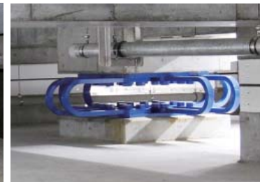
■ 免震層内の鋼材ダンパー (例)
