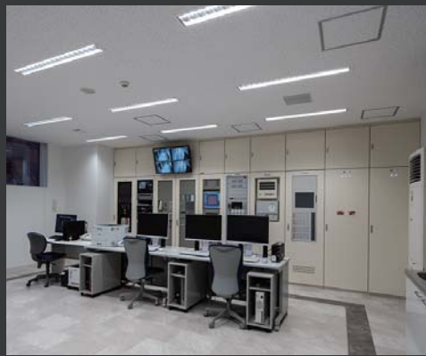
1階：防災センター
