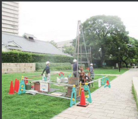
観測井戸の設置
