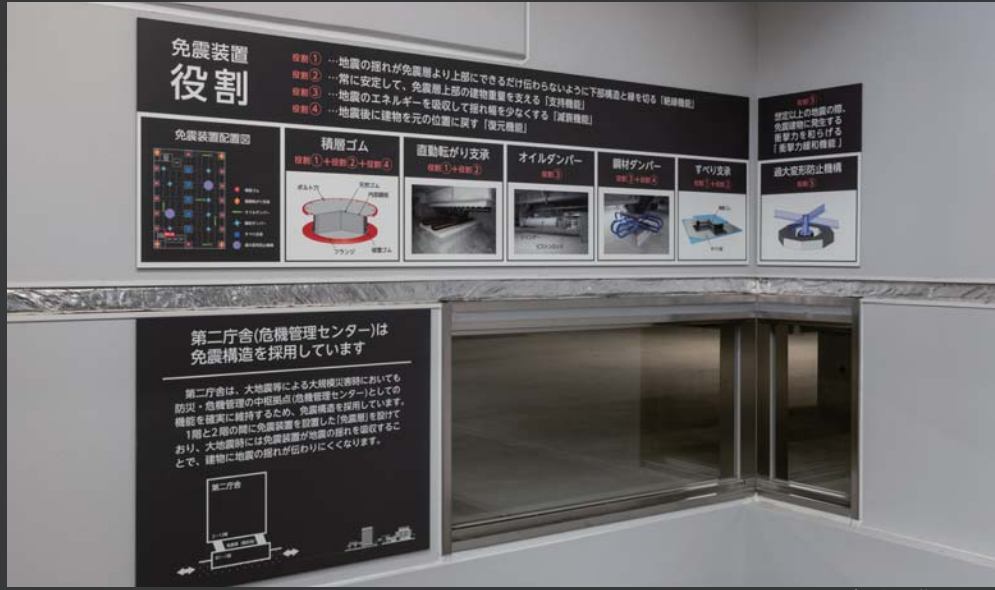
免震層見学スペース
