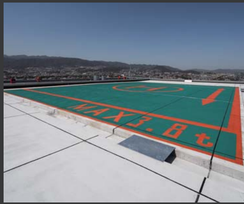
屋上：ヘリポート
