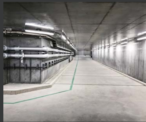
本庁舎と第二庁舎をつなぐ地下連絡通路
