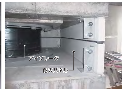
■免震装置 外観 (例: アイソレータと耐火パネル)
