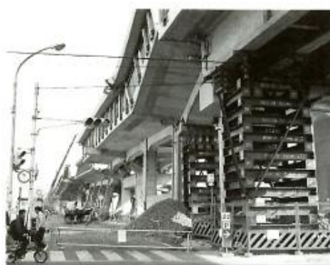
損壊した新幹線の橋脚部分には大きな鉄骨が組まれ、急ピッチで復旧作業が進められた。
