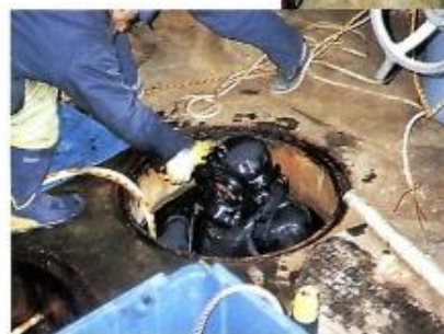
武庫川浄水場でダイバーによる調査。
