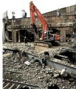
▲復旧作業工事
