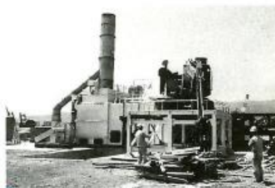
甲子園浜の仮設焼却炉
