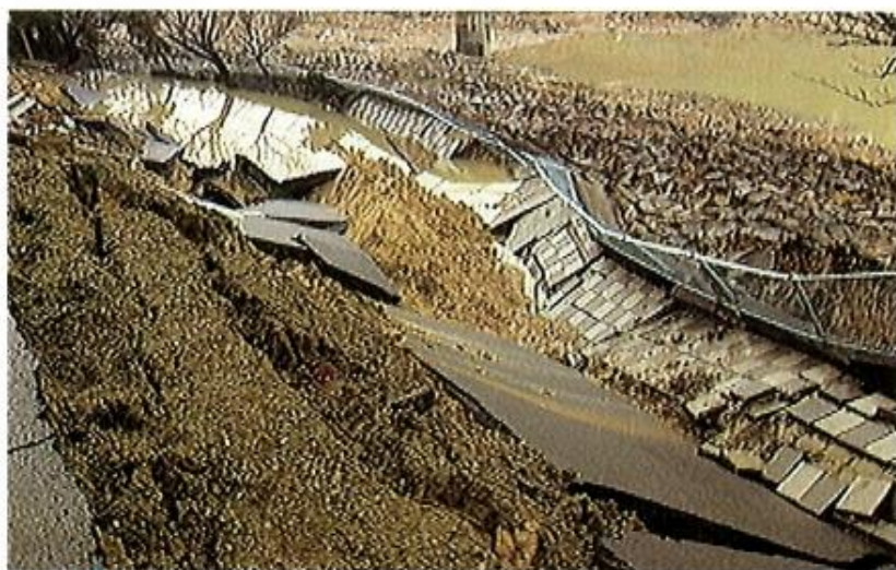
上・中・下3つの池の間の堤が崩壊したニテコ池貯水池。
