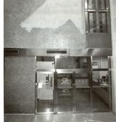
上は市庁舎6~8階が使用不能となったため、市庁舎横に建てられた仮庁舎。下は市庁舎1階ロビー部分。
