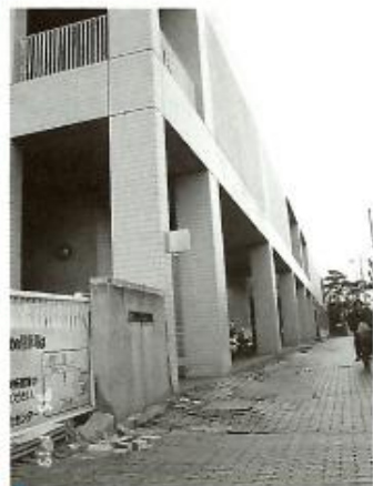
比較的被害の少なかった中央図書館。しかし、前の歩道部分が損壊。内部の書架が倒れ、本が散乱した。2月18日から再開。
