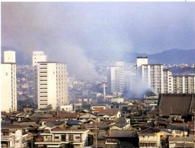
西宮市内で41件の火事が発生（JR西ノ宮駅北側）
