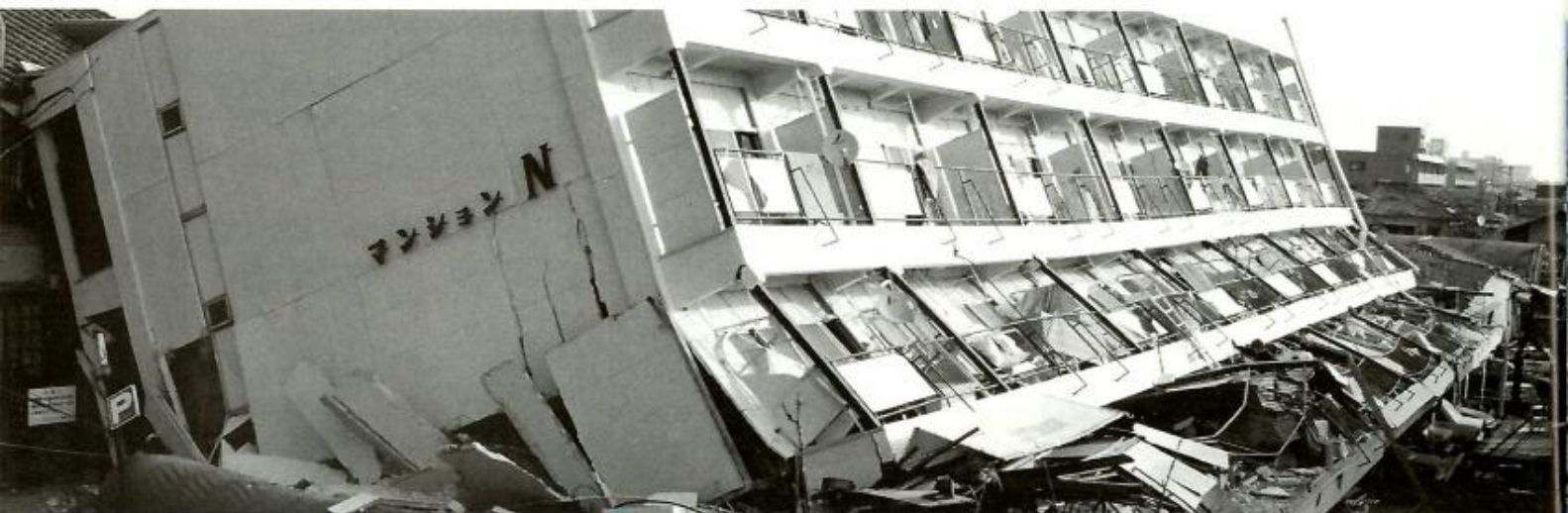
震度7の地震は多くのマンションも倒壊させた。(安井町)
