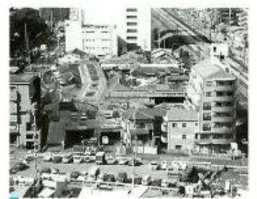
壊滅的な打撃を受けた卸売市場。
