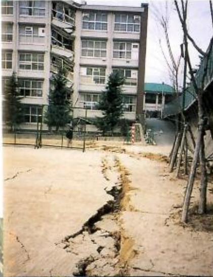
市立西宮高校のグラウンドに走る地割れ。校舎も損壊した。
