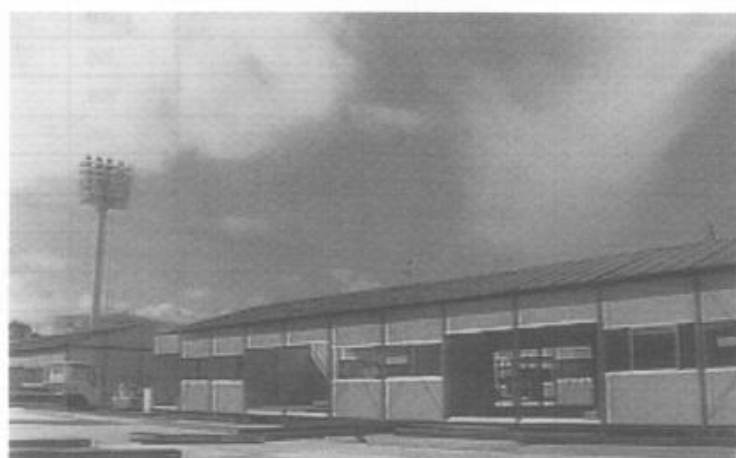
応急仮設住宅の建設
