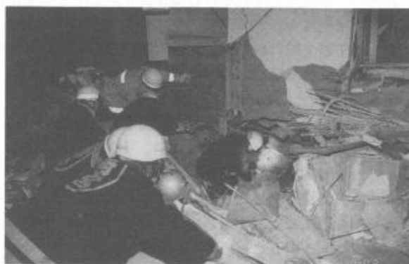
倒壊家屋内で救出活動を続ける消防団員(青木町)
