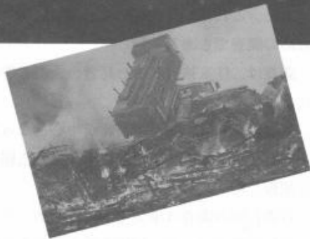
上／膨大な量の廃材の山 下／甲子園浜での野焼きによる処分
