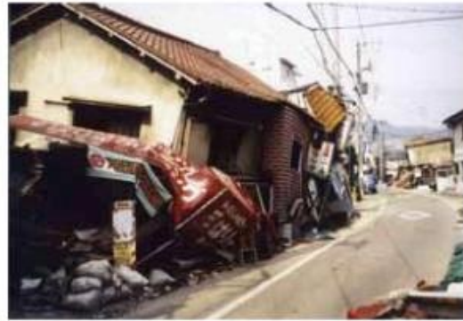
被災状況（旧 屋敷町 2 番街区）
