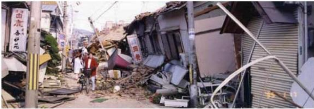
被災状況（旧 屋敷町 2 番街区）
