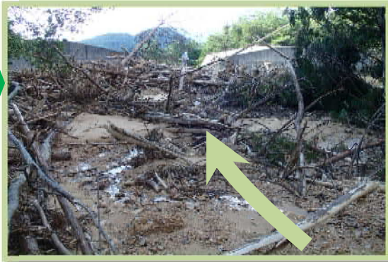
山口地区 東船坂堰堤 土砂捕捉状況 (出典：国土交通省 近畿地方整備局 六甲砂防事務所)
