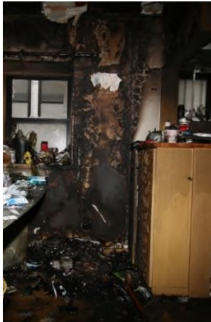
写真 1-1 出火箇所の焼損状況
