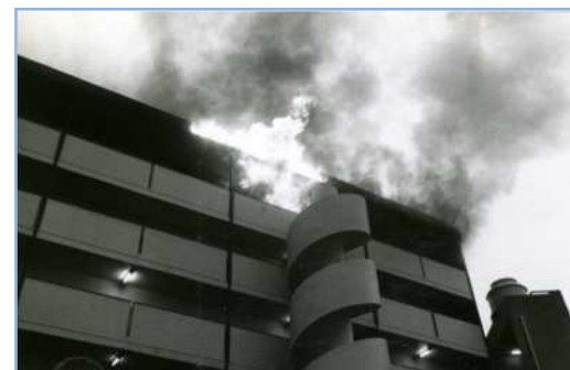
昭和52年（門戸荘） マンション都市ガス爆発火災
