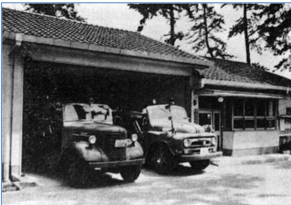
昭和37年当時の西宮消防署夙川出張所 （結善町）
