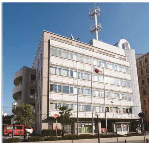
現在の消防局庁舎 （池田町）
