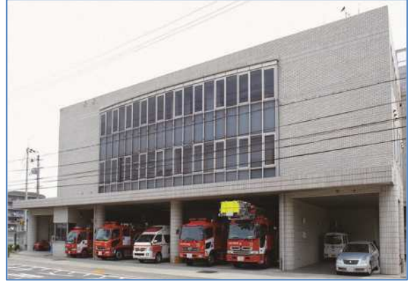
現在の瓦木消防署 （高木東町）
