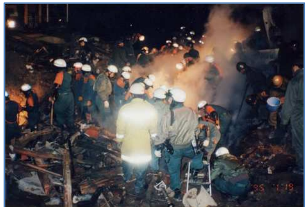
不眠不休の消火・救助活動が3日間続けられた 土砂崩れ現場(仁川百合野町)
