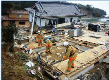
津波被害家屋の検索活動(第1次派遣隊・南三陸町)
