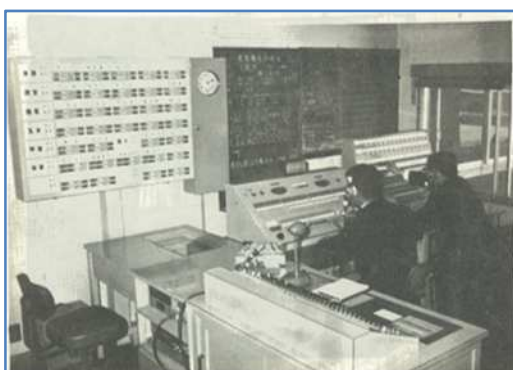
昭和41年当時の管制室(指令室)
