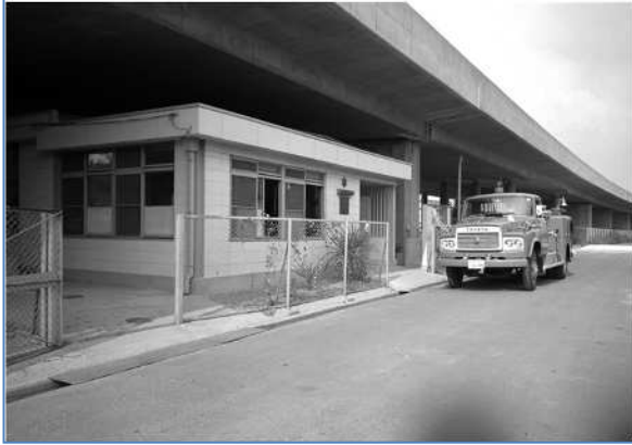
昭和42年の西宮消防署瓦木出張所 （大屋町）
