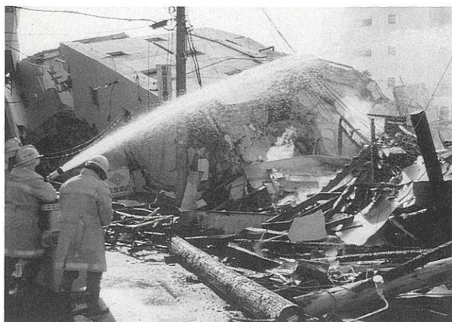
消火作業中の消防団員（甲子園口北町）
