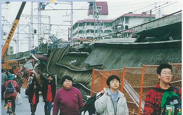
高架の道床が崩れた阪急電車・神戸線（若松町）
