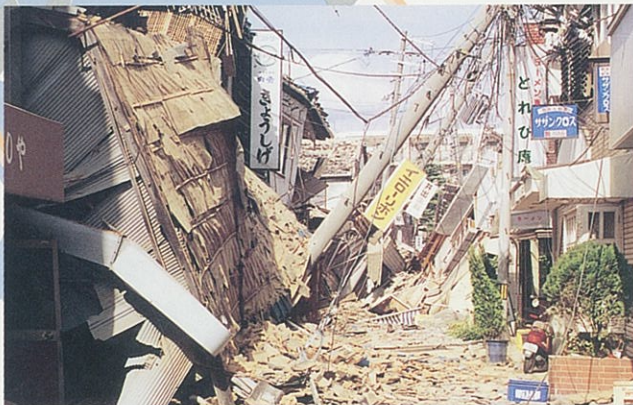
商店街は倒壊家屋や破損した電柱で道を塞いだ （甲東園1丁目・甲東園市場）
