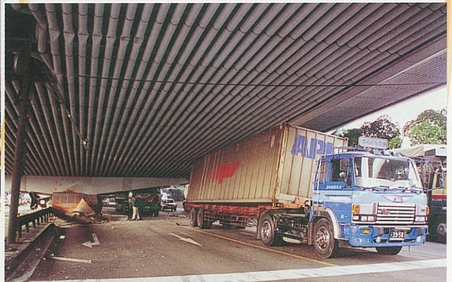
阪神高速・神戸線高架の下敷きとなった車両 (市庭町付近)
