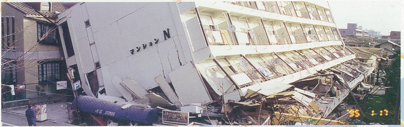
1階ピロティ部分が崩れ倒壊したマンション（安井町）
