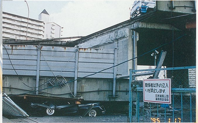
落橋し走行中の乗用車が下敷きとなった名神高速道路 (高畑町)
