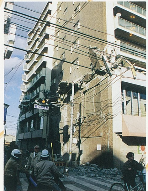
中間層が破壊した大型店舗付マンション (津門大塚町)
