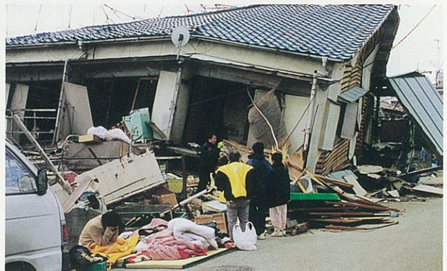
倒壊した2階建ての共同住宅では1階居住者に多くの犠牲者を生じた（青木町）
