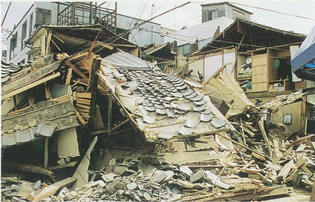
倒壊した住宅（上田市1丁目）
