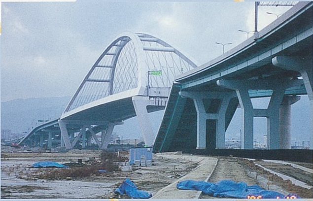
落橋した阪神高速・湾岸線では走行中の車両も犠牲となった (甲子園浜 2 丁目)
