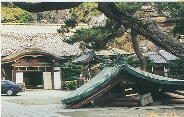
西宮神社の被災状況（社家町）
