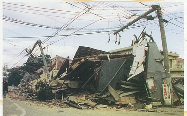
軒並みに倒壊した住宅（青木町）
