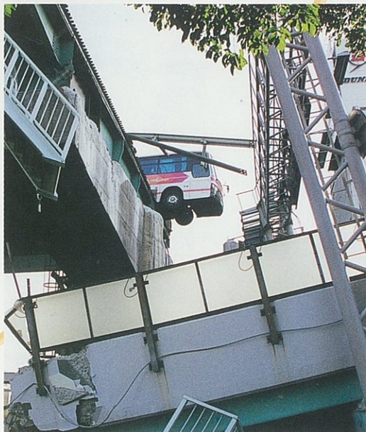
落橋した阪神高速・神戸線上で間一髪、転落を免れた長距離スキーバス (本町付近)
