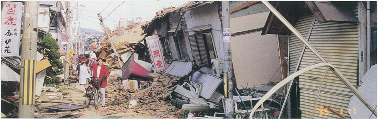
倒壊した香栢園市場（屋敷町）
