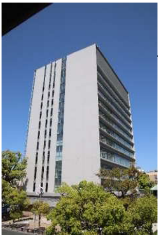
西宮市役所第二庁舎（危機管理センター） 西宮市消防局
