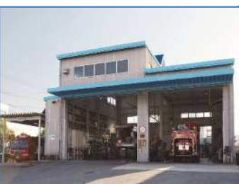
消防局整備センター
