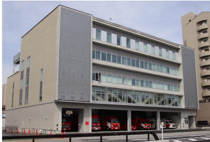
西宮消防署 消防庁舎棟
