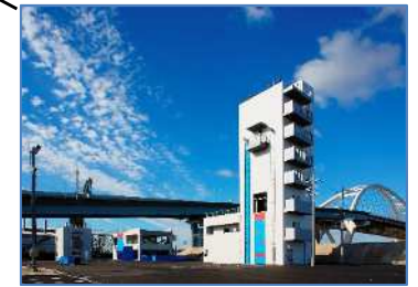
西宮市消防訓練施設
