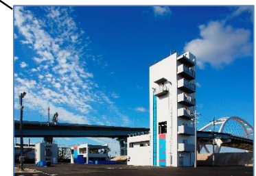
西宮市消防訓練施設
