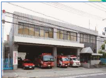
西宮消防署北夙川分署
