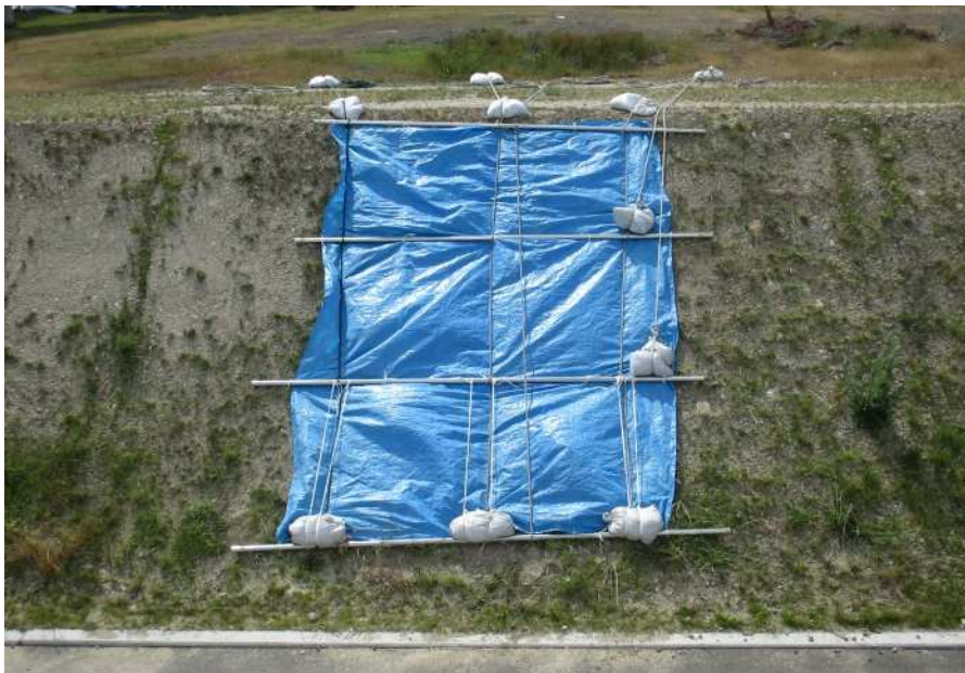
水防工法訓練
