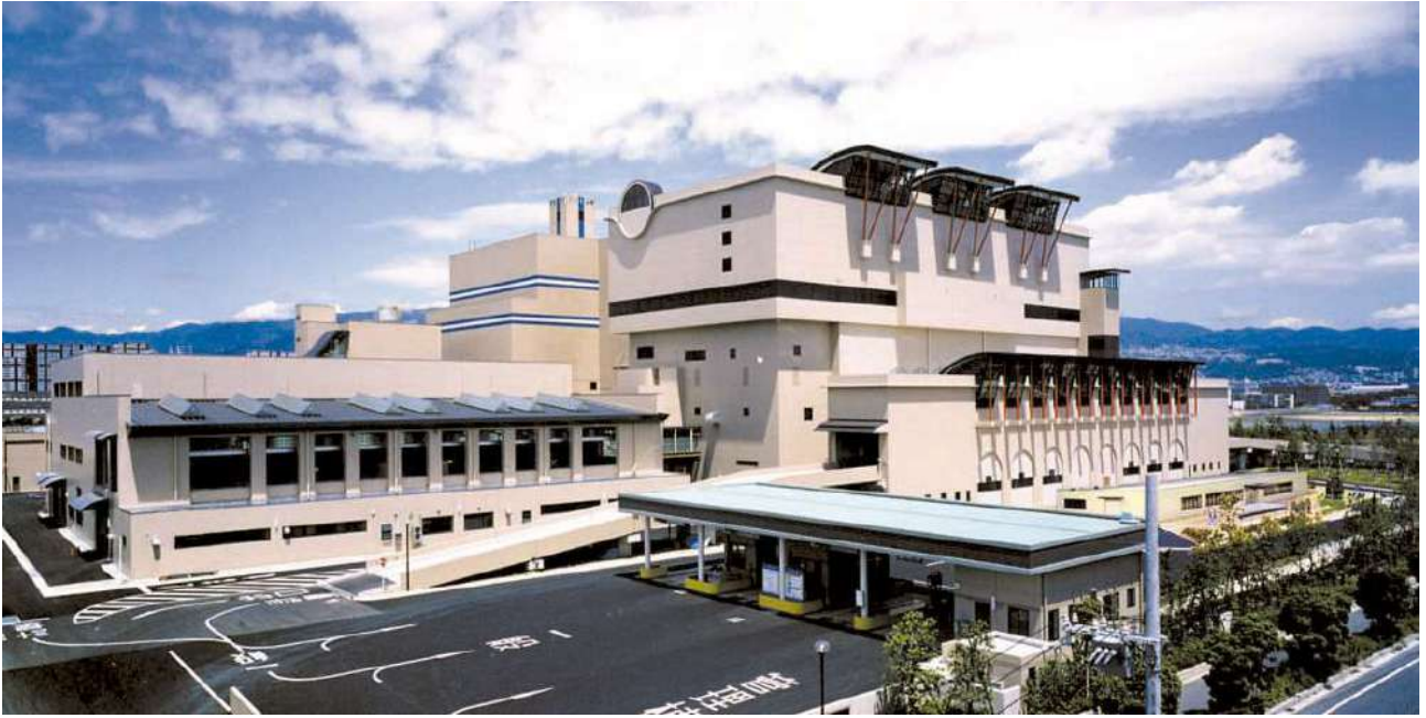
西部総合処理センター
