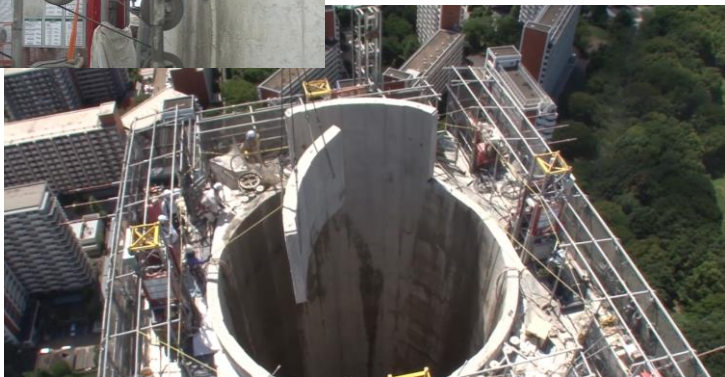
クレーン吊り降ろし
