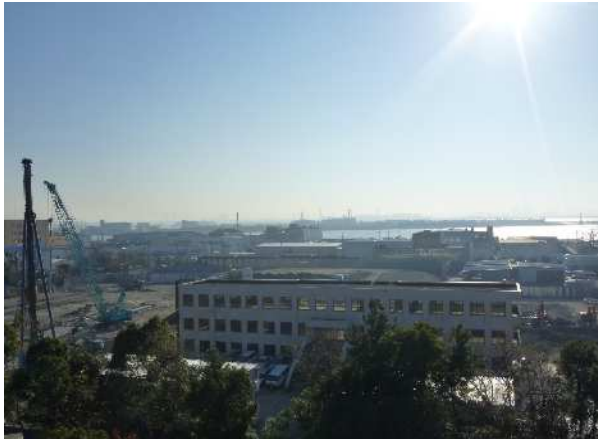
工事現場全景(西側より)
