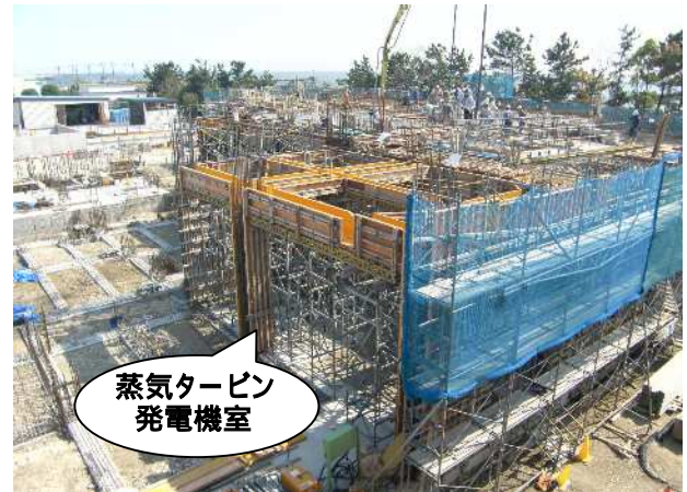
工事現場全景(南側)
