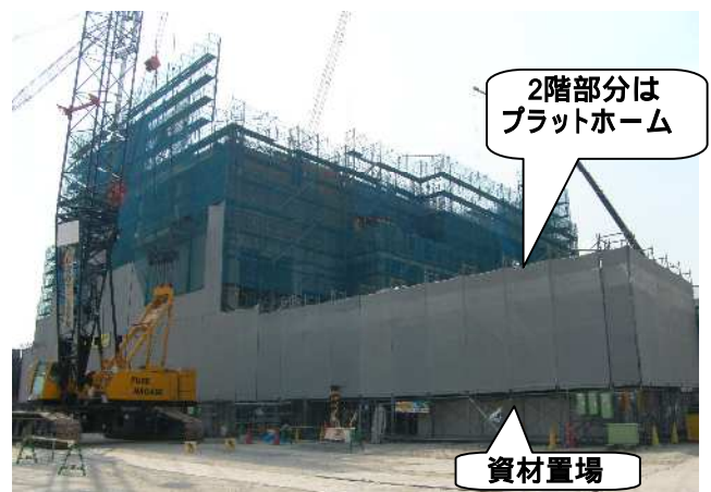
建築施工状況(北東側より)
