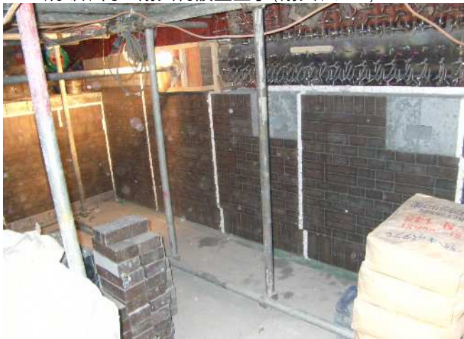
焼却炉内の耐火物設置工事(耐火レンガ)
