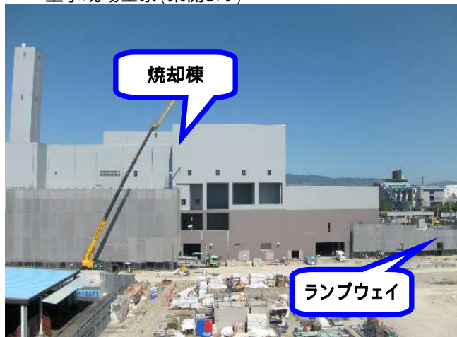
工事現場全景(東側より)
