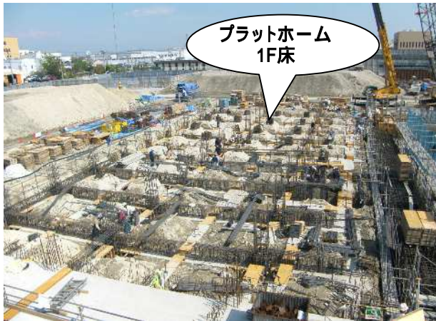
工事現場全景(北側)
