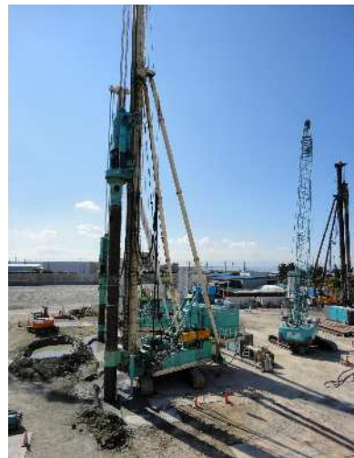
地中障害物除去
