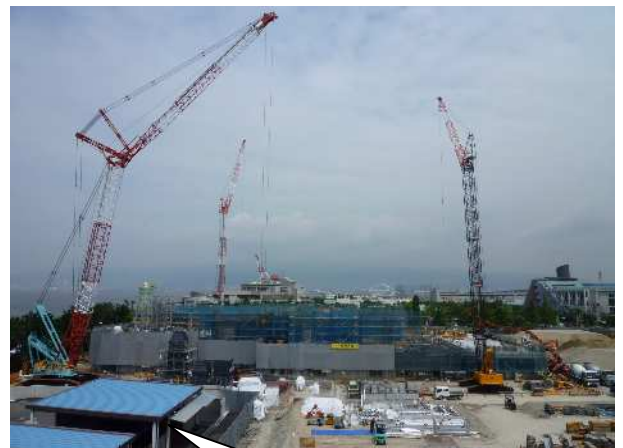
工事現場全景(東側より)
