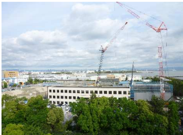
工事現場全景(西側より)
