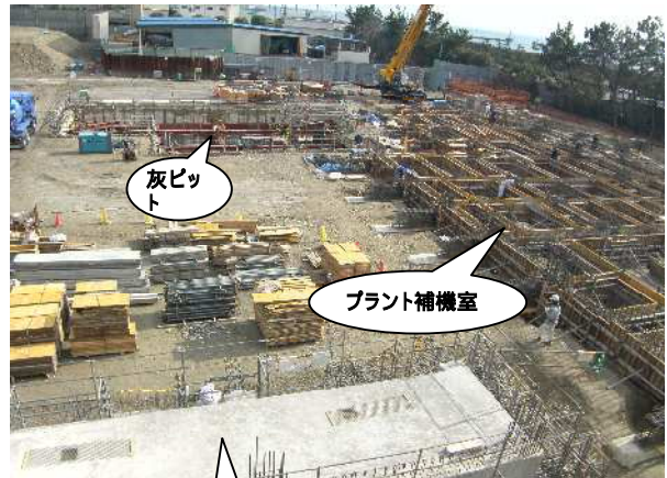
灰ピット、プラント補機室、共同溝
