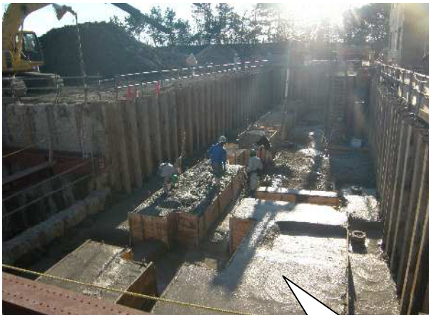
共同溝部分掘削
