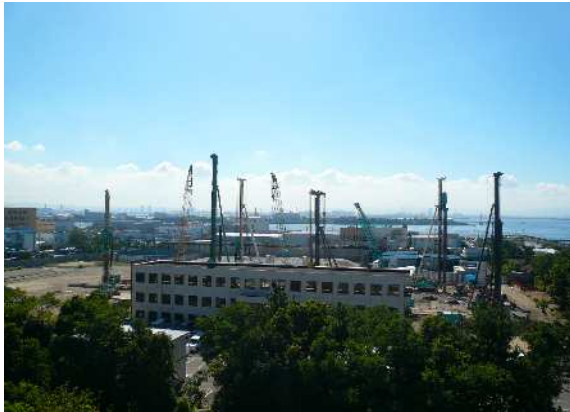
既存施設跡地(西側より)
