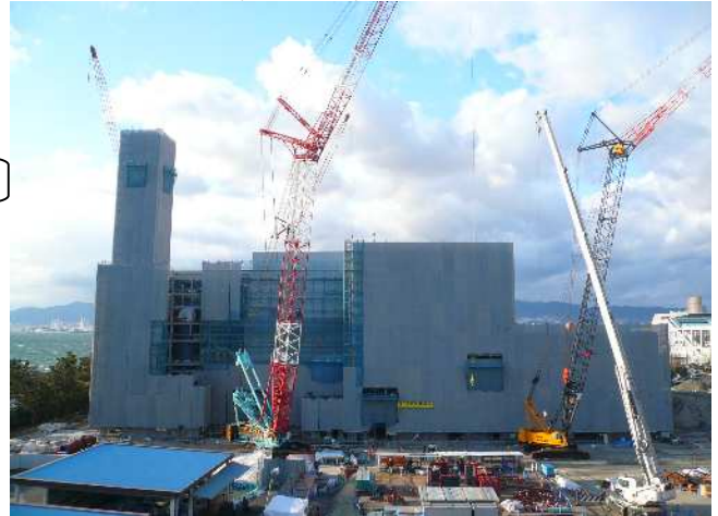
工事現場全景(東側より)
