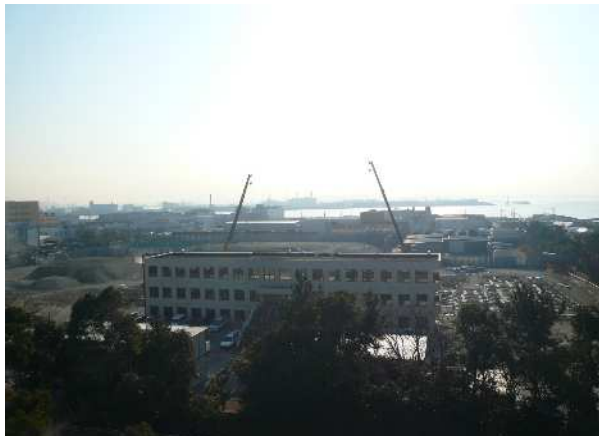
工事現場全景(西側より)
