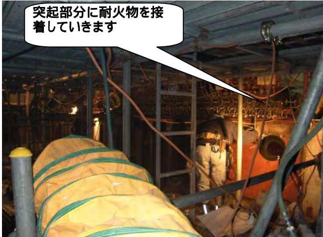
焼却炉内の耐火物設置工事
