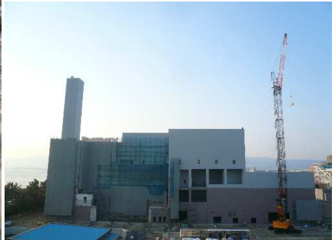
工事現場全景(東側より)
