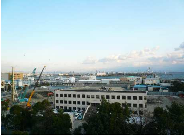
工事現場全景(西側より)
