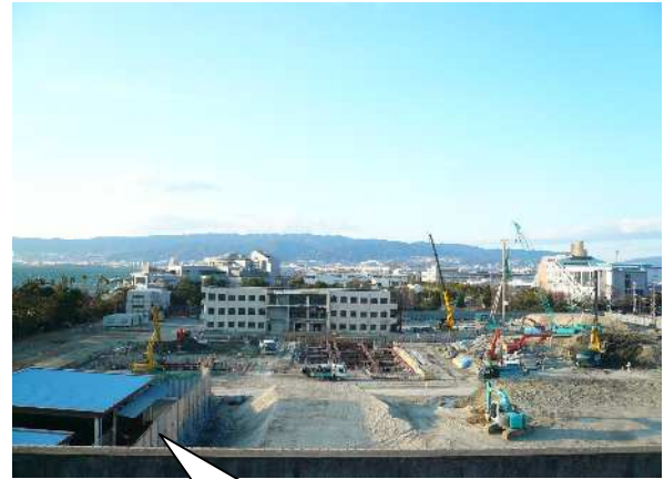
工事現場全景(東側より)
