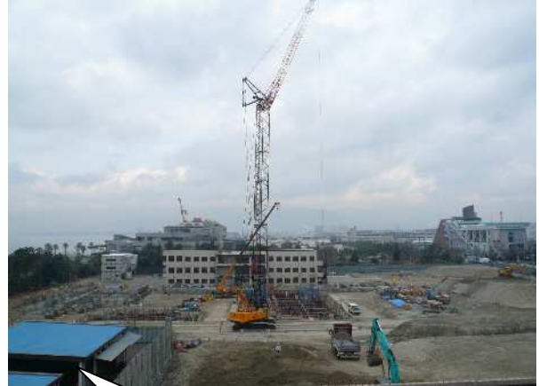
工事現場全景(東側より)
