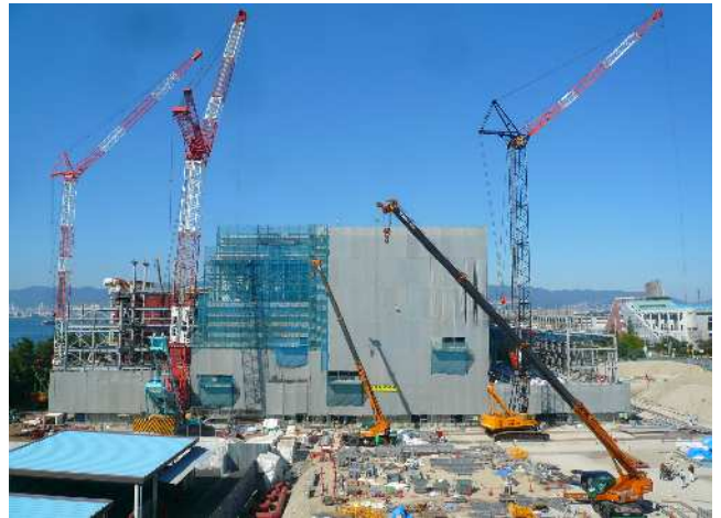
工事現場全景(東側より)
