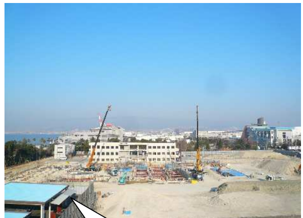
工事現場全景(東側より)
