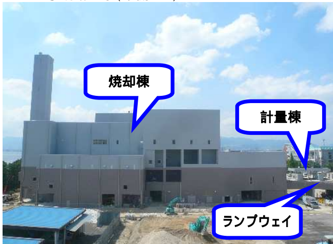
工事現場全景(東側より)
