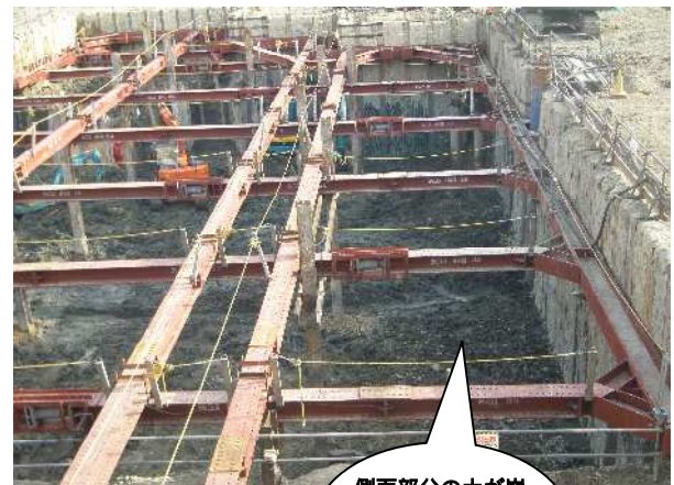
ごみピット部分掘削
