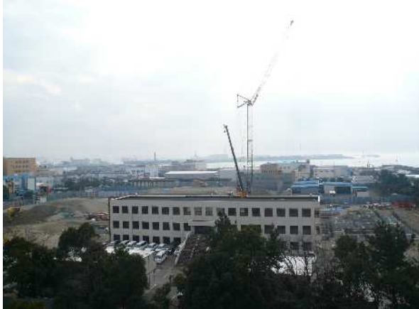
工事現場全景(西側より)
