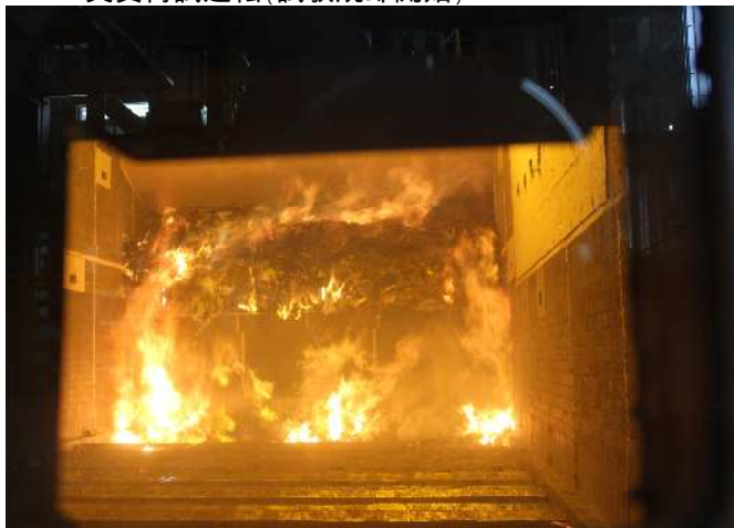
実負荷試運転(試験焼却開始)
