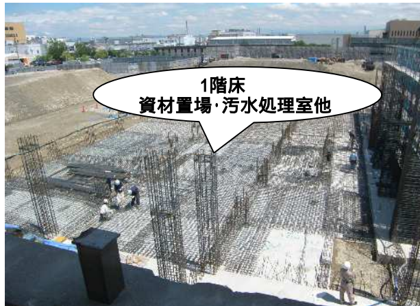
工事現場全景(北側)
