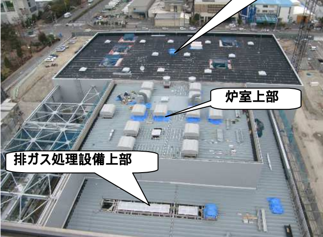
工事現場全景(煙突上部から撮影)
