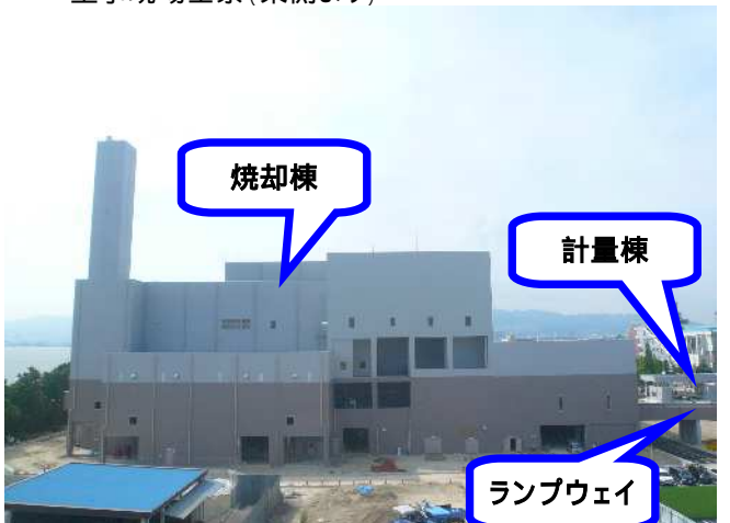
工事現場全景(東側より)
