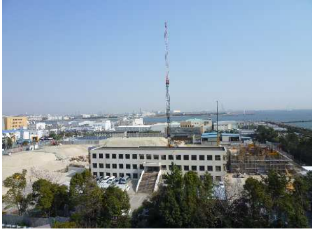
工事現場全景(西側より)
