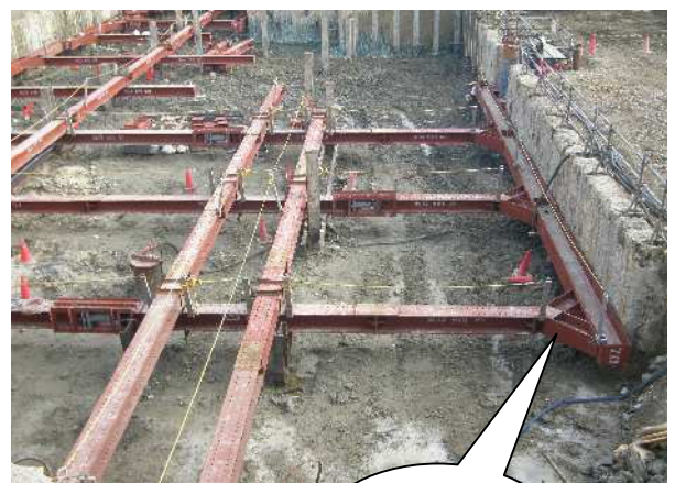
ごみピット部分掘削
