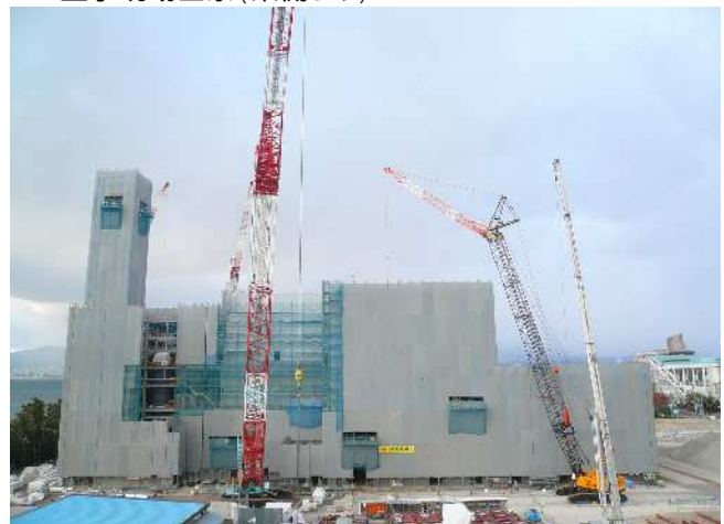
工事現場全景(東側より)
