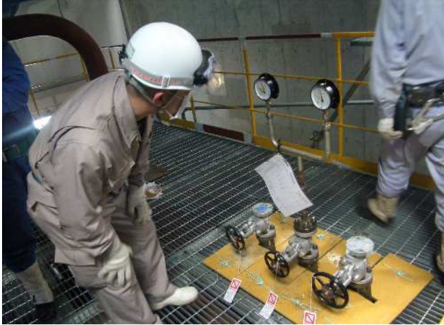
ボイラー水圧試験の様子(2月29日実施)
