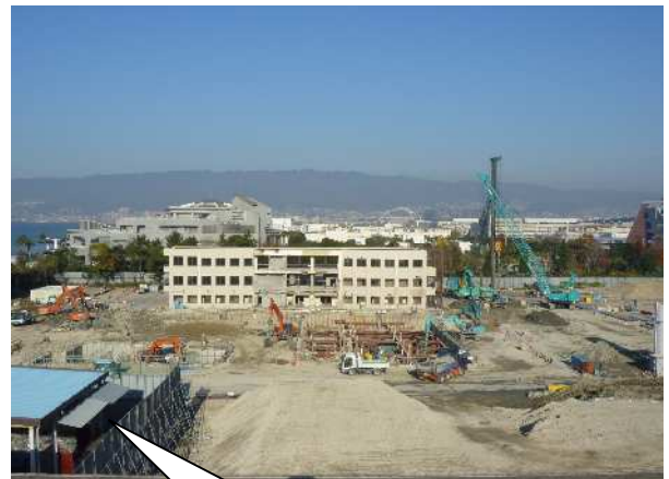
工事現場全景(東側より)
