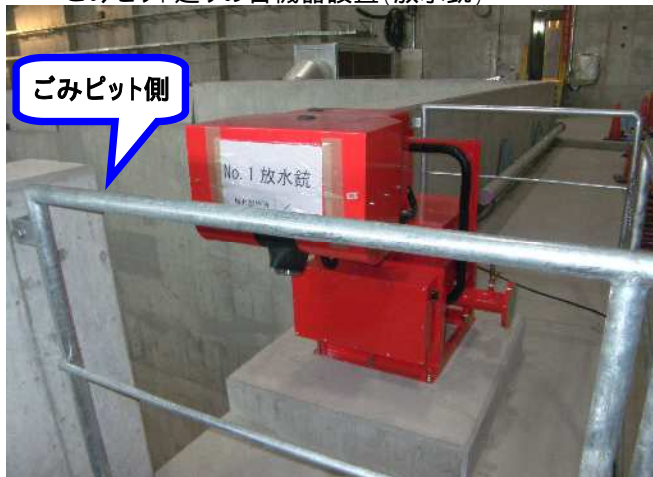
ごみピット廻りの各機器設置(放水銃)
