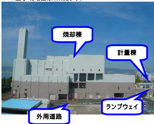
工事現場全景(東側より)
