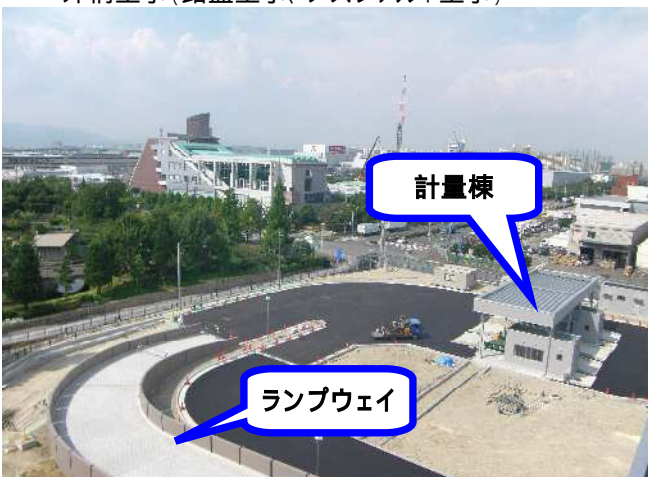
外構工事(路盤工事、アスファルト工事)
