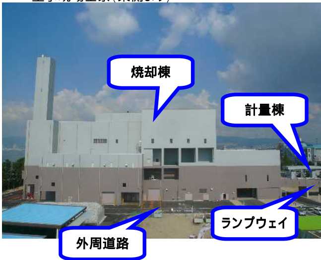
工事現場全景(東側より)
