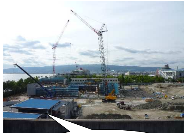
工事現場全景(東側より)
