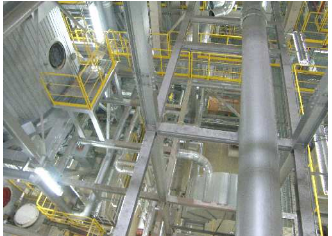
焼却炉炉室内(足場解体後の写真)
