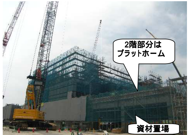
建築施工状況(南東側より)
