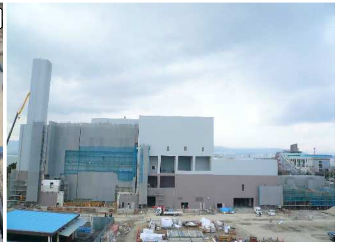
工事現場全景(東側より)
