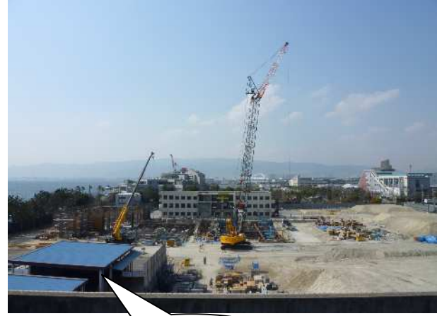
工事現場全景(東側より)
