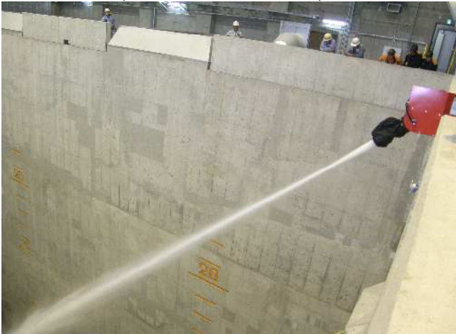
消防検査(放水銃設備 放水テスト)
