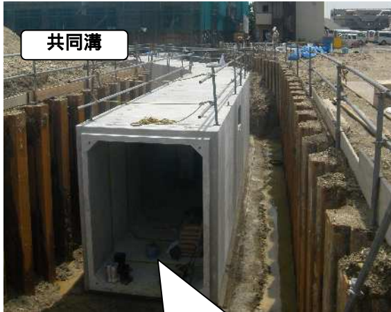
工事現場(北西側)
