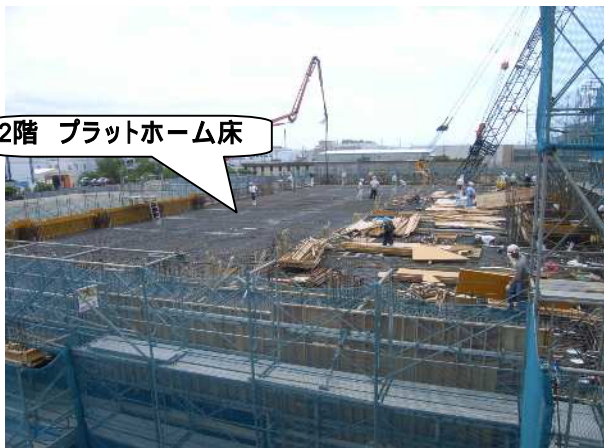
工事現場全景(北側)
