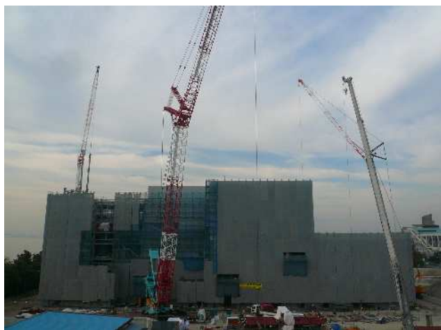
工事現場全景(東側より)
