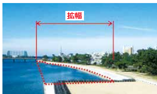
武庫川総合治水工事箇所
