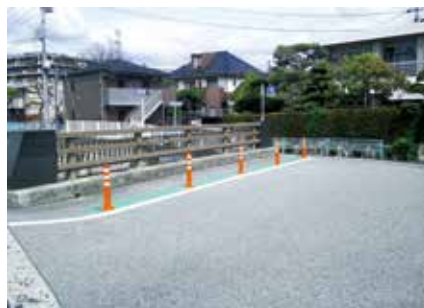
安全対策実施例(ポストコーン設置)
