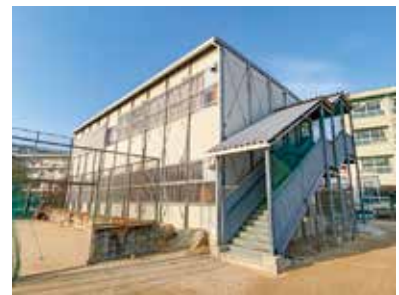
真砂中学校の仮設校舎
