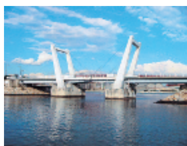
御前浜橋 (はね橋)
