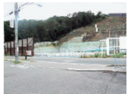
国道176号(八幡トンネル東側付近)
