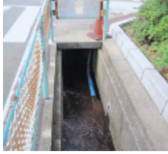
上水放水作業の様子
