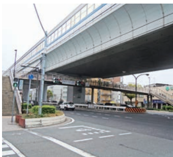
国道43号線横断歩道橋
