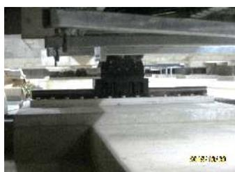
写真左は横揺れに対する免震装置で横揺れ65cmまで対応出来ます。右写真装置は縦揺れに対する構造です。
