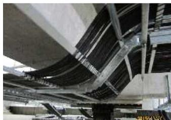
切断しない様床下部分は固定しているが基礎部分との接続配線は固定されず可動式になっている。
