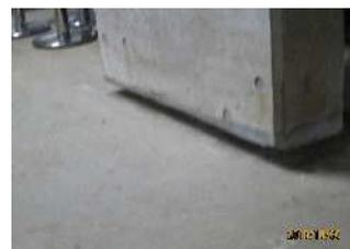
写真左を見て頂くと分かりますが、基礎部分と固定せずに数センチ浮いているのが分かりますが、免震装置によるものです。
