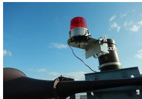
防災スピーカーに設置するパトライトのイメージ
