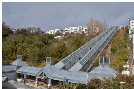
東山台斜行エレベーター
