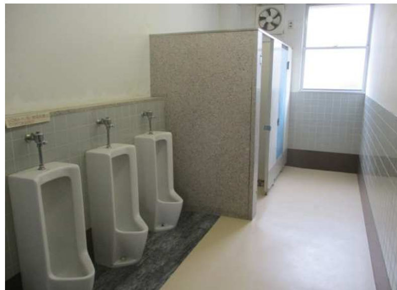
改修後のトイレ
