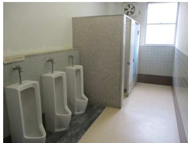
改修後のトイレ
