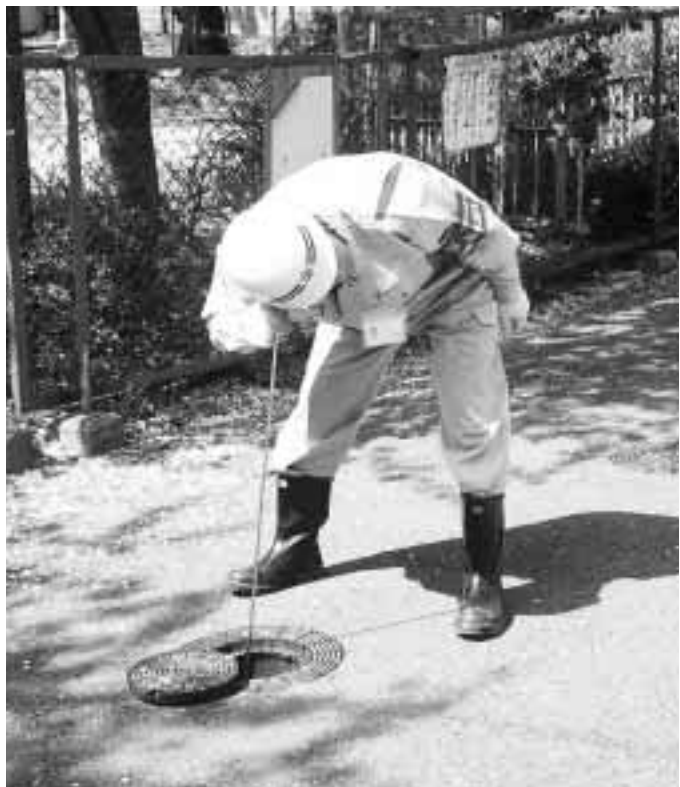
漏水の音聴調査作業
