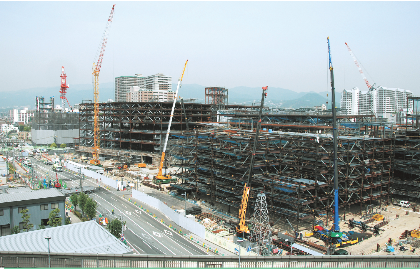
大型商業施設「阪急西宮ガーデンズ」のオープンや甲南大学マネジメント創造学部の開校に向け、建設が進む阪急西宮北口駅周辺。活力と魅力にあふれる文教住宅都市「西宮」へ
