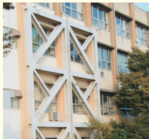
耐震補強後(苦楽園中)
