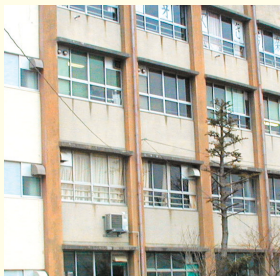
耐震補強前(苦楽園中)
