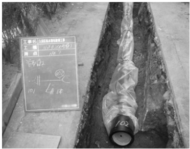
耐震管への布設替工事
