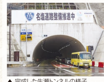
▲ 完成した生瀬トンネルの様子
