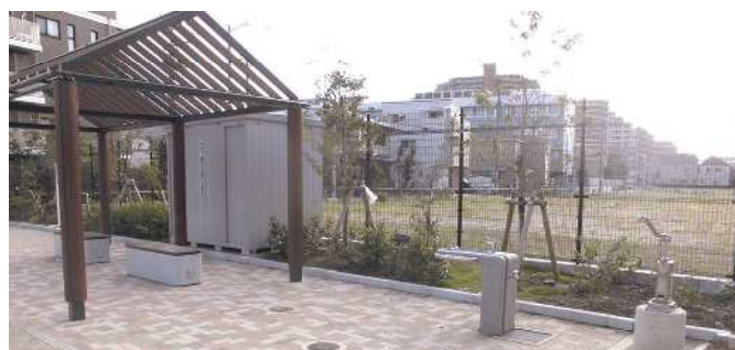
防災機能を有した公園施設の配置(防災パーゴラ、手押しポンプなど)
