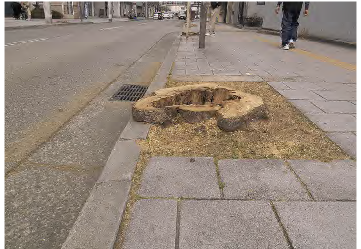
伐採した危険木(福祉センター筋)
