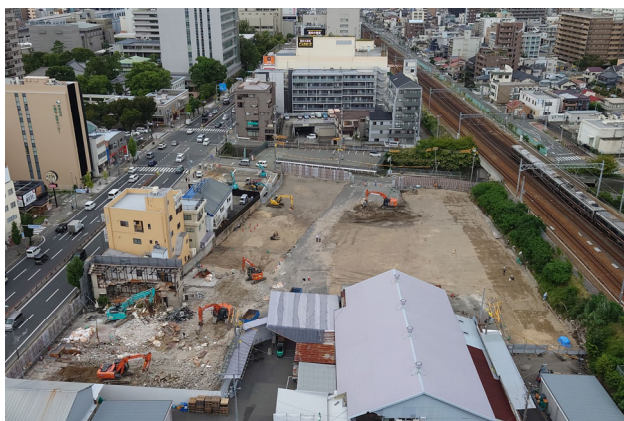
写真：A街区東側から撮影
