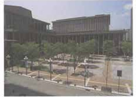
全景(東側より)
