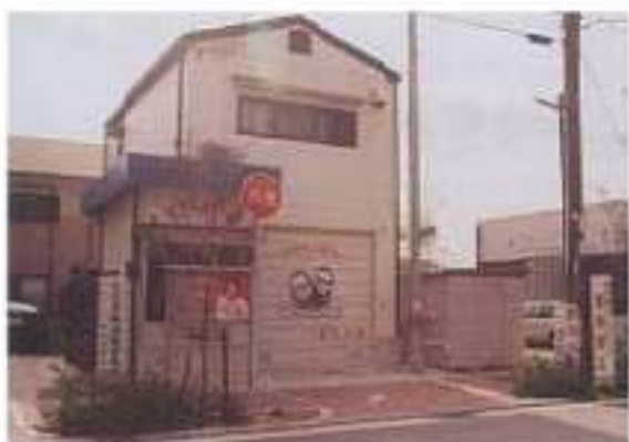
消防分団車庫 (森貝公園に隣接)
