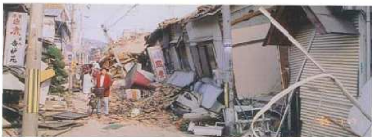
倒壊家屋により道路が塞がれています。(旧 厩敷町2番街区・平成7年1月17日)
